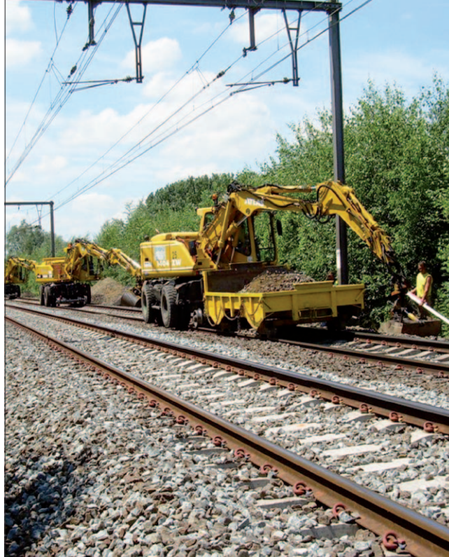
TRAVAUX FERROVIAIRES – N'est pas opérateur qui veut sur les chantiers d'Infrabel. Des examens doivent être passés pour décrocher son permis rail-route.
